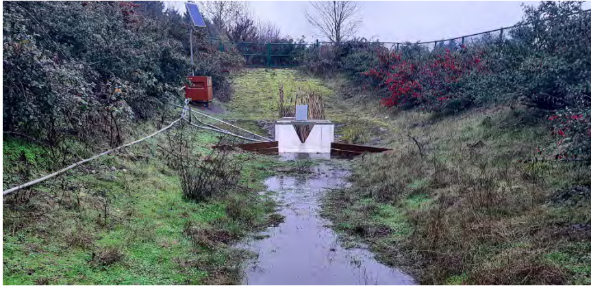
Figure 3. Vancouver bioswale effluent
