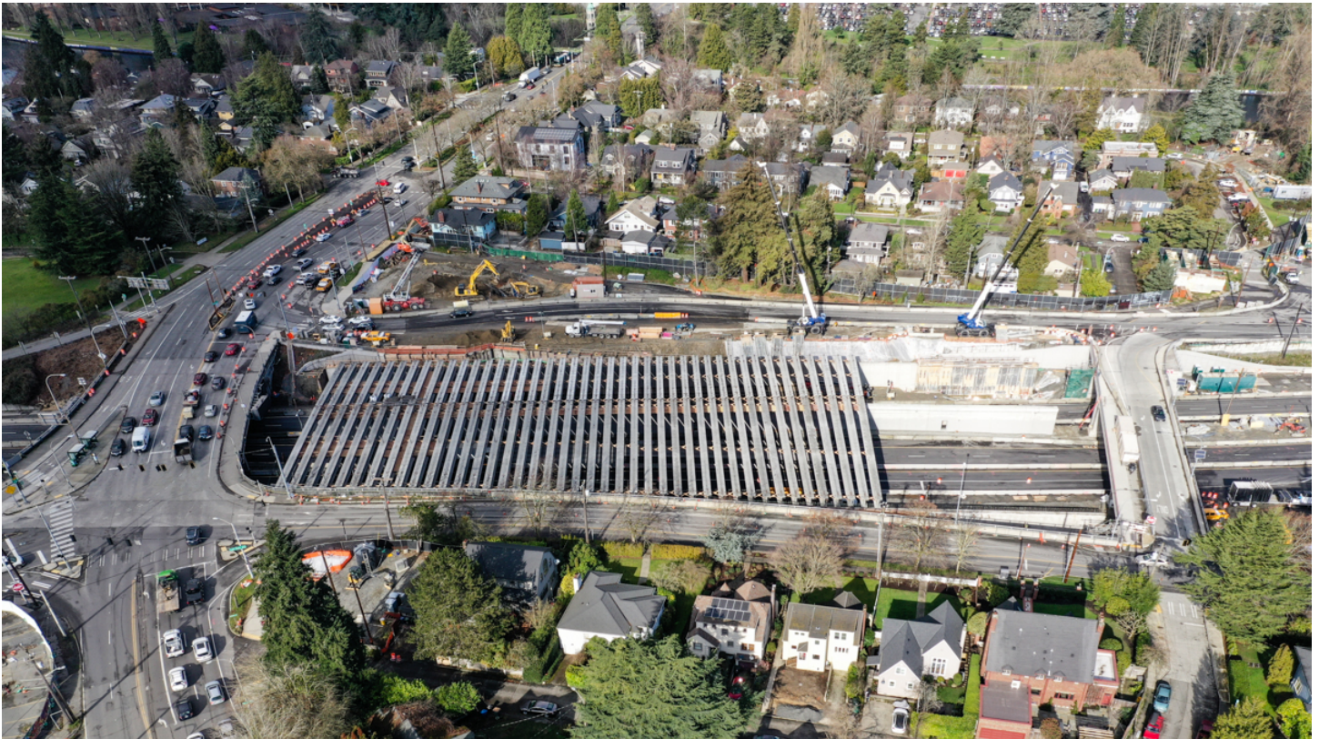
Nắp Montlake dần hình thành, khi đội dự án đặt 84 dầm đầu tiên cho mặt nền của nắp.
