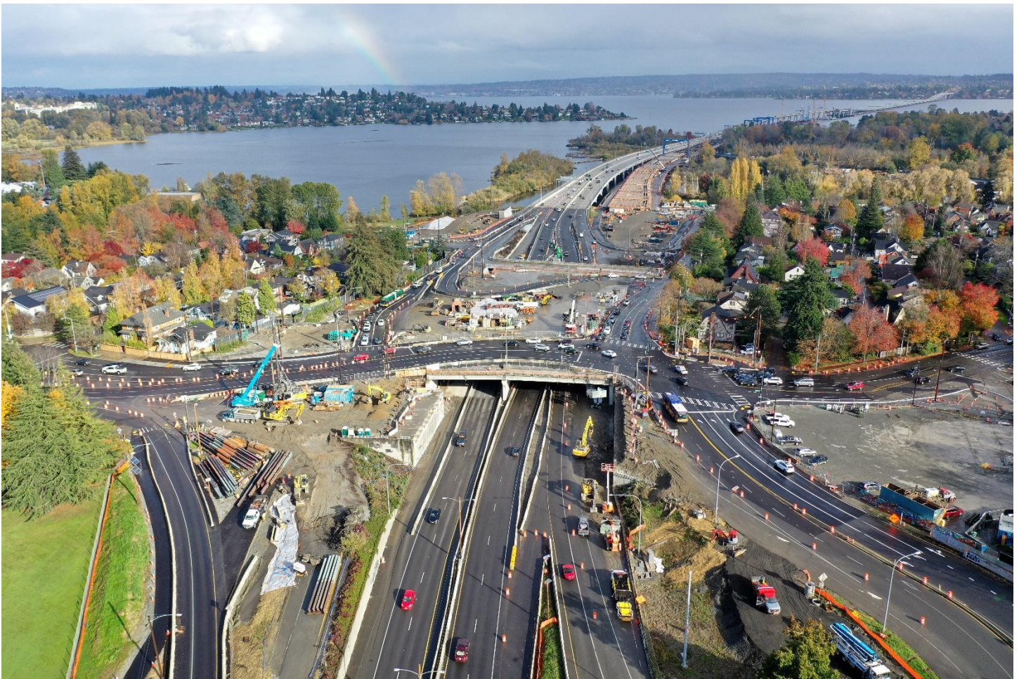
Nakatingin sa silangan sa kabila ng SR 520/Montlake Boulevard interchange, na kinabibilangan ng bagong takip ng Montlake na ginagawa.
