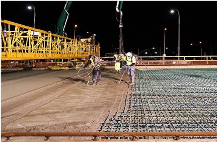
Left: Gumagamit ang mga tauhan ng malaking bridge-deck paver upang maglagay ng kongkreto para sa hinaharap na takip ng Montlake sa itaas ng SR 520. Ito ang una sa anim na pagbuhos ng semento sa gabi para sa bahaging ito ng takip. Right: Isa pang view ng mga tauhan ng makina na ginamit sa paglalagay ng kongkreto para sa takip ng Montlake.
