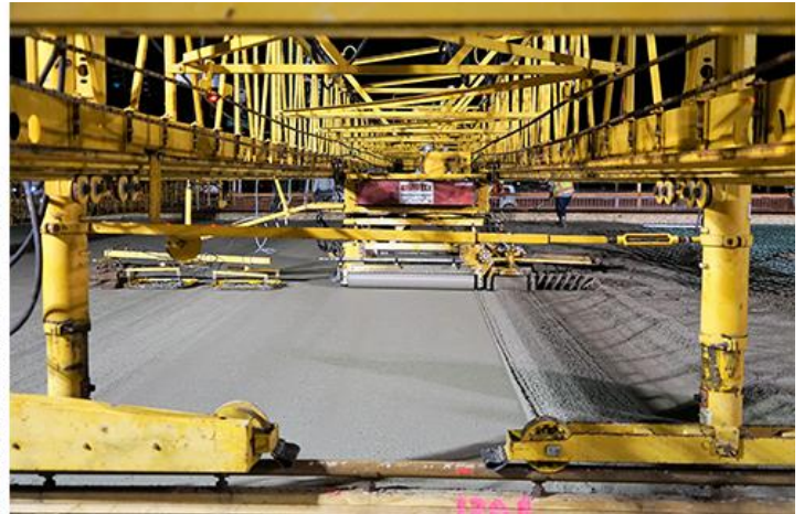
Left: Gumagamit ang mga tauhan ng malaking bridge-deck paver upang maglagay ng kongkreto para sa hinaharap na takip ng Montlake sa itaas ng SR 520. Ito ang una sa anim na pagbuhos ng semento sa gabi para sa bahaging ito ng takip. Right: Isa pang view ng mga tauhan ng makina na ginamit sa paglalagay ng kongkreto para sa takip ng Montlake.
