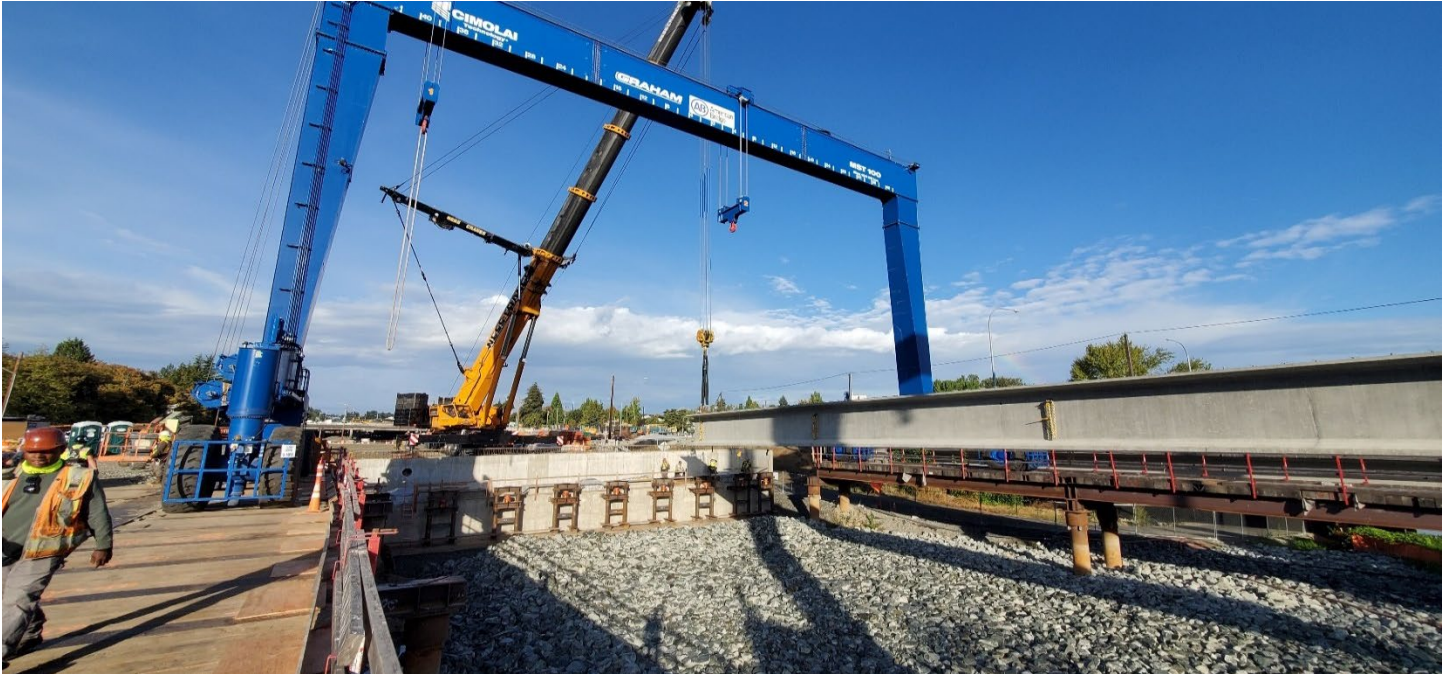
Los equipos utilizan grandes grúas de pórtico para colocar las primeras vigas de un nuevo puente SR 520 en dirección este sobre Union Bay.
