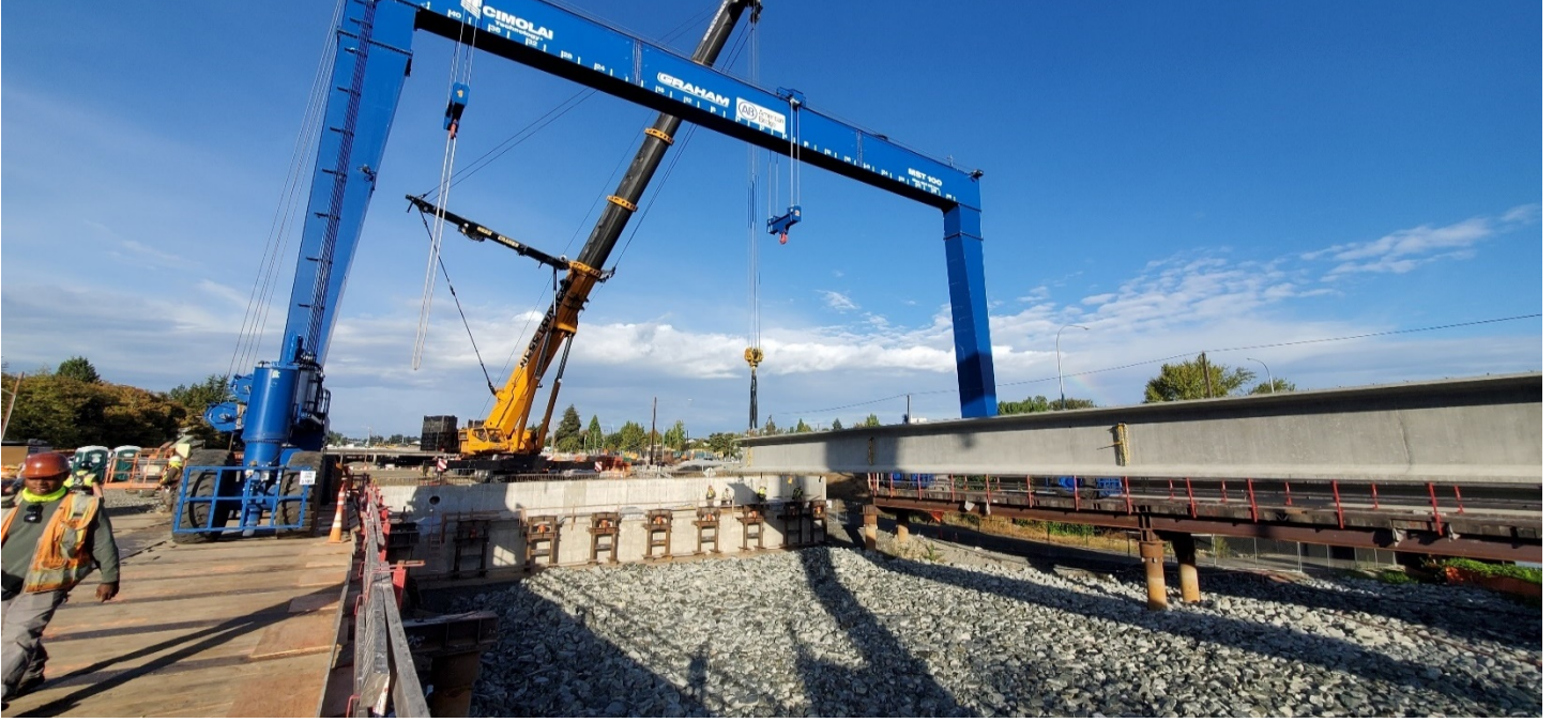
चित्र 6: कर्मी दल यूनियन बे पर एक नए पूर्वाभिमुख SR 520 पुल के पहले गर्डर लगाने के लिए बड़ी गैन्ट्री क्रेनों का इस्तेमाल कर रहा है।
