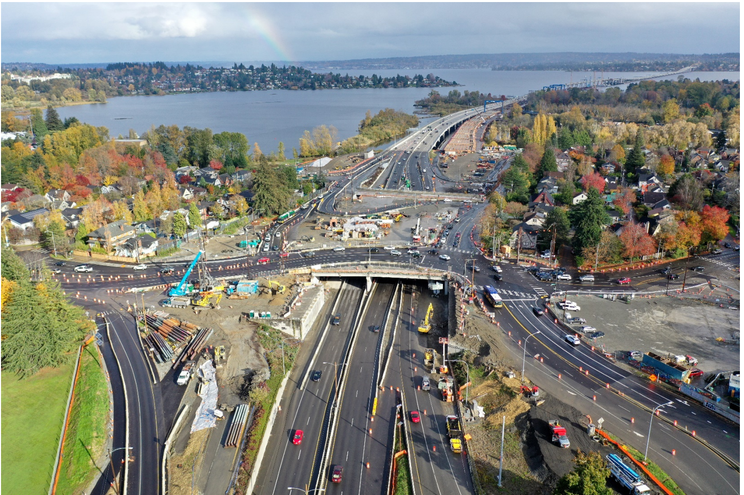
圖十：向東看，穿過 SR 520/Montlake 大道交匯處，其中包括正在施工的蒙特萊克頂蓋。
