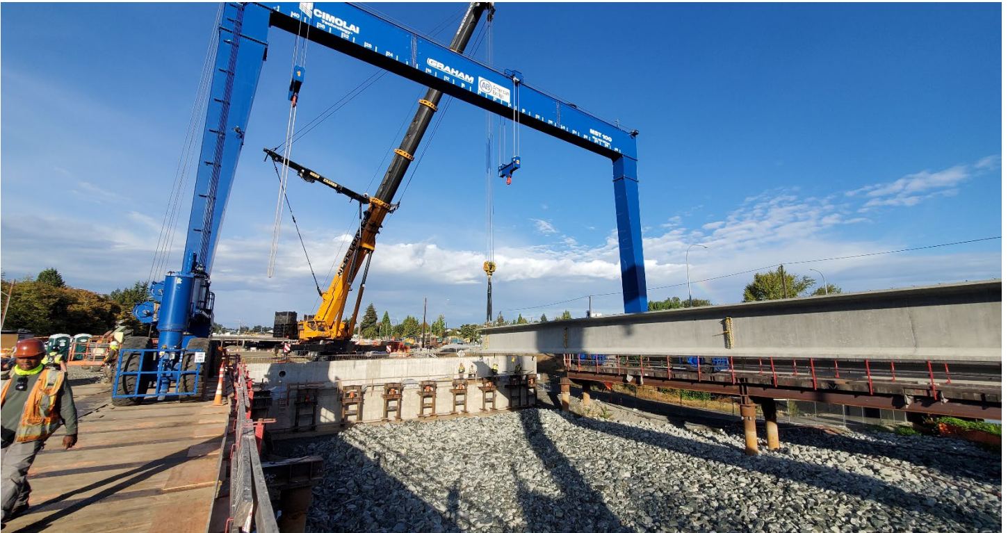
圖六：工作人員使用大型龍門起重機在 Union Bay 的新東向 SR 520 橋放置第一根大梁。
