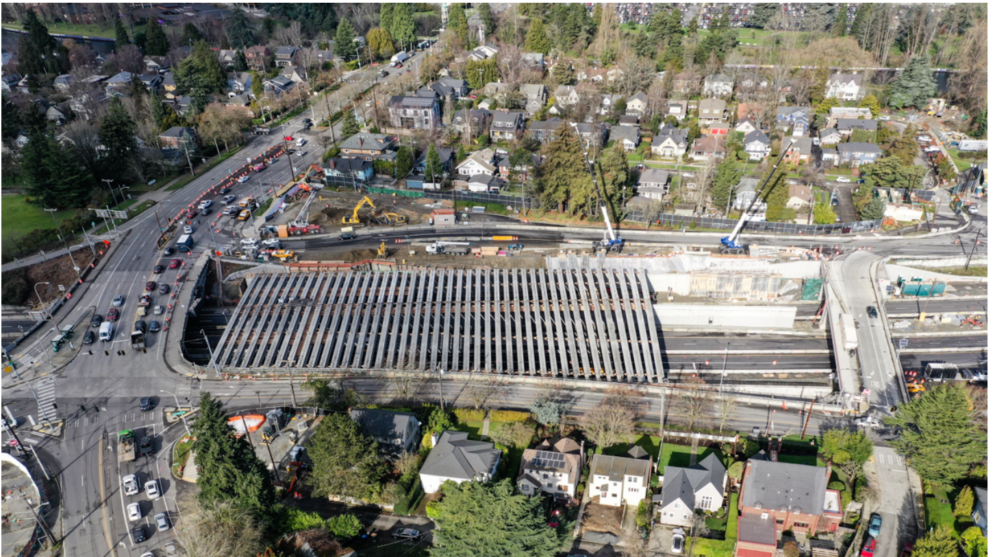
當工作人員為頂蓋的基礎架設了首批 84 根大梁後，蒙特萊克頂蓋(Montlake lid)開始成形。
